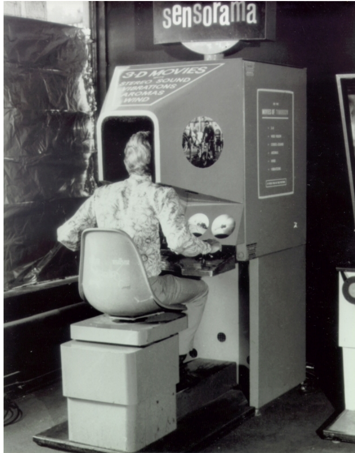
“Sensorama” (Morton Heilig, 1962). Se trataba de un simulador de motocicleta interactivo. Integraba imágenes cinematográficas en 3D, sonido, vibración y olfato.
